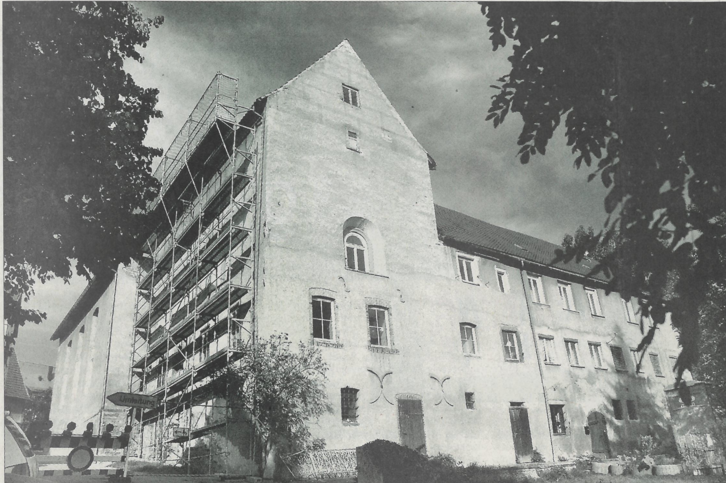
Die Stadt renoviert mit finanzieller Hilfe des ausgezeichneten Vereins das Kapuzinerkloster
